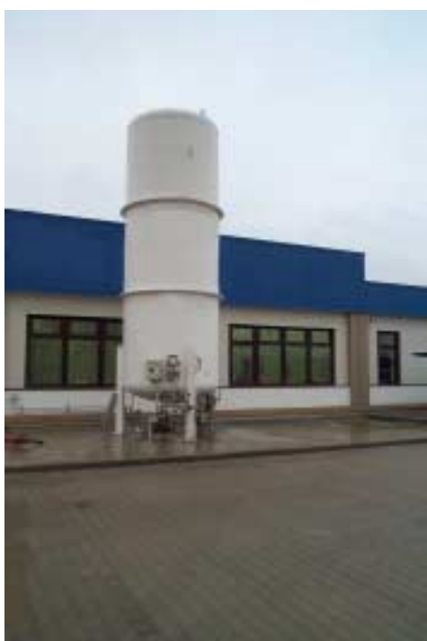
Obr. 11: Stabilní zásobník pro oxid uhličitý
